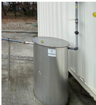
Figure 10 : Pot à condensats
